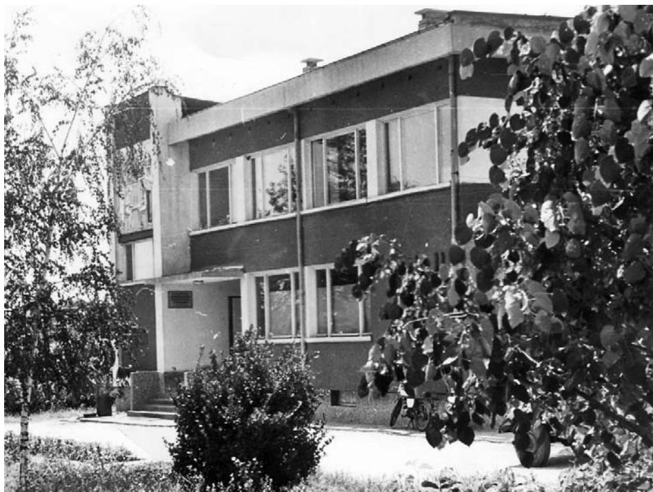
Фиг. 5. Сградата на Бубарската Изпитателна и Контролна Станция в Харманли
